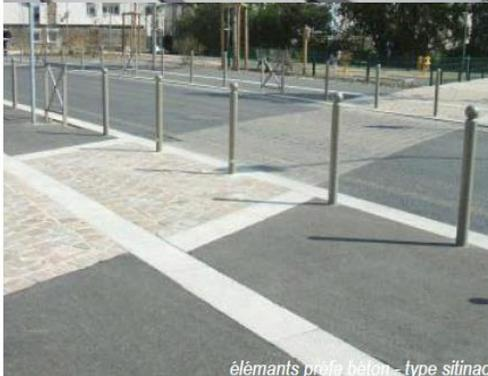
éléments préfa béton - type silinao
